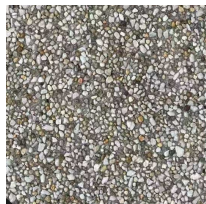
露石混凝土地坪（淺色米白）
